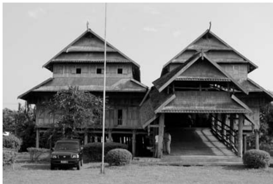
スンパワ島旧王宮(スンパワ・ブサル) 1885年建設の木造大建築。高床、妻入りの建物を2棟並べたような特徴あるつくり。軸部の歪みなど破損が進んでいる
