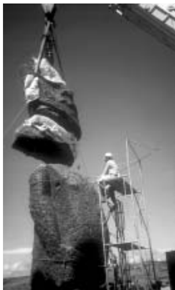
図5 宙吊り状態での接合作業(口絵カラー参照)
