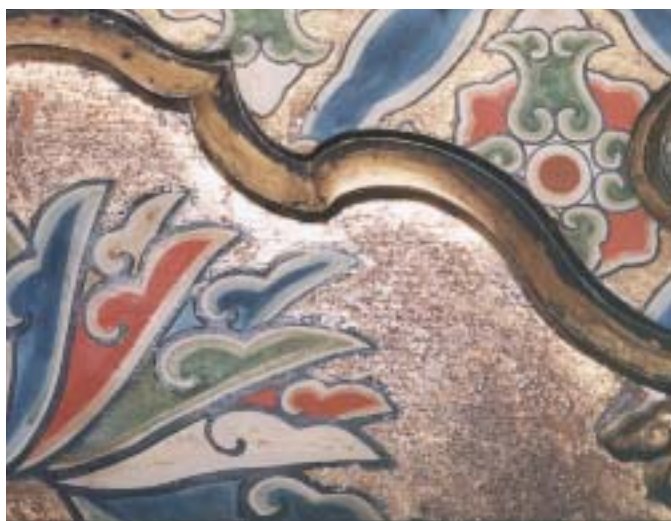
写真3 剥落止め処置後
